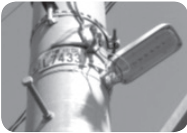
電柱共架のLED防犯灯 (例)港北区L7433 故障時対応：自治会担当まで 従来の自治会管理番号を連絡 して下さい。
